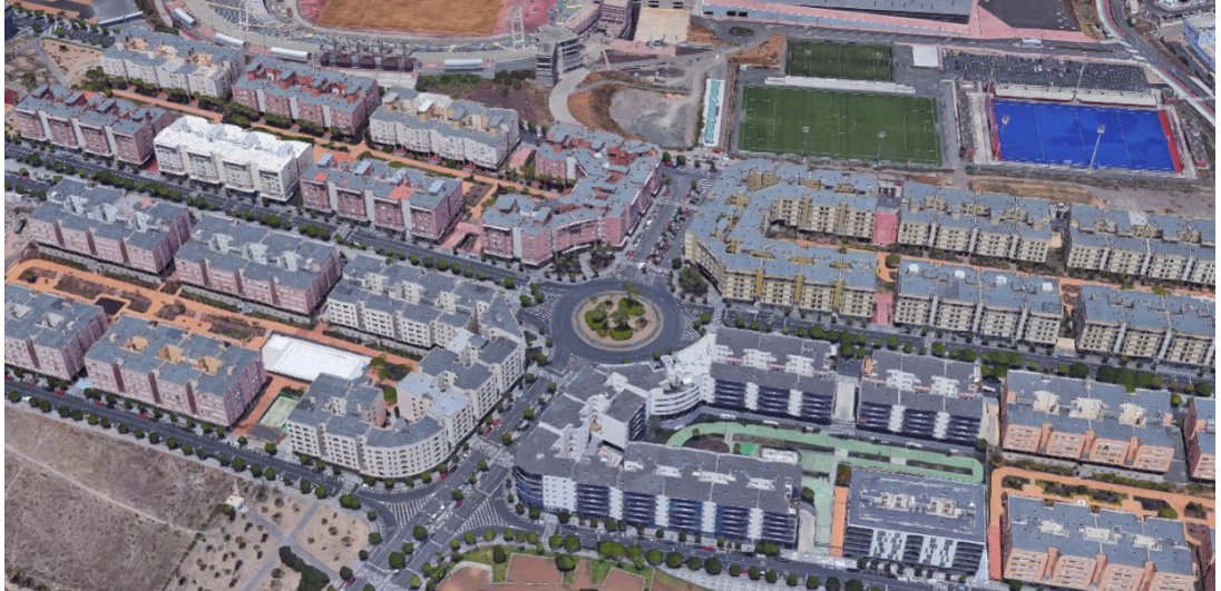
Área regulada por la Norma Zonal A (manzana abierta) en la zona de 7 Palmas.
