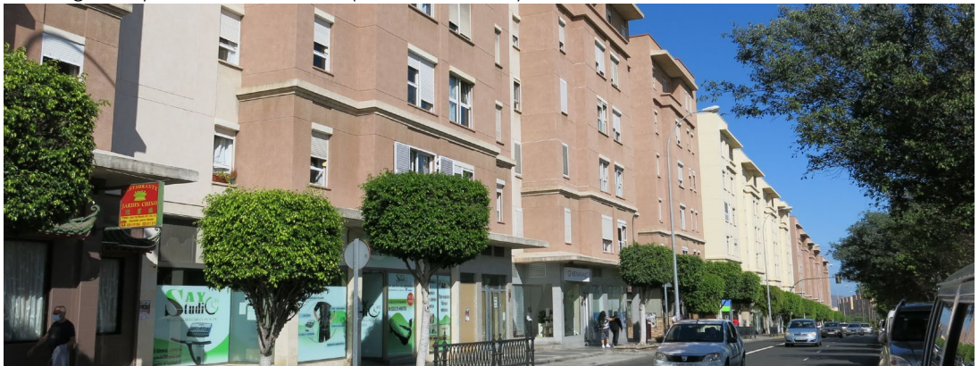
Bajos comerciales en el ámbito de la norma zonal A.
