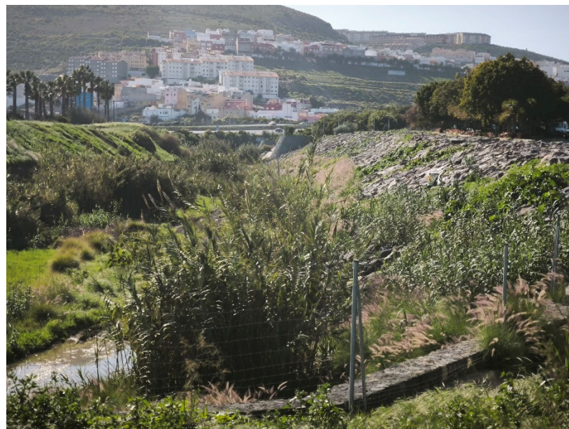
Imagen global del ámbito en sentido Este-Oeste
