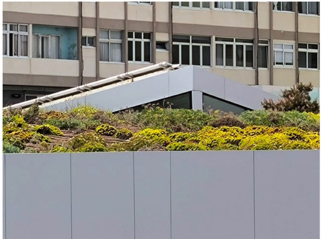
Cubierta verde en edificio público-municipal. Playa de Las Canteras
