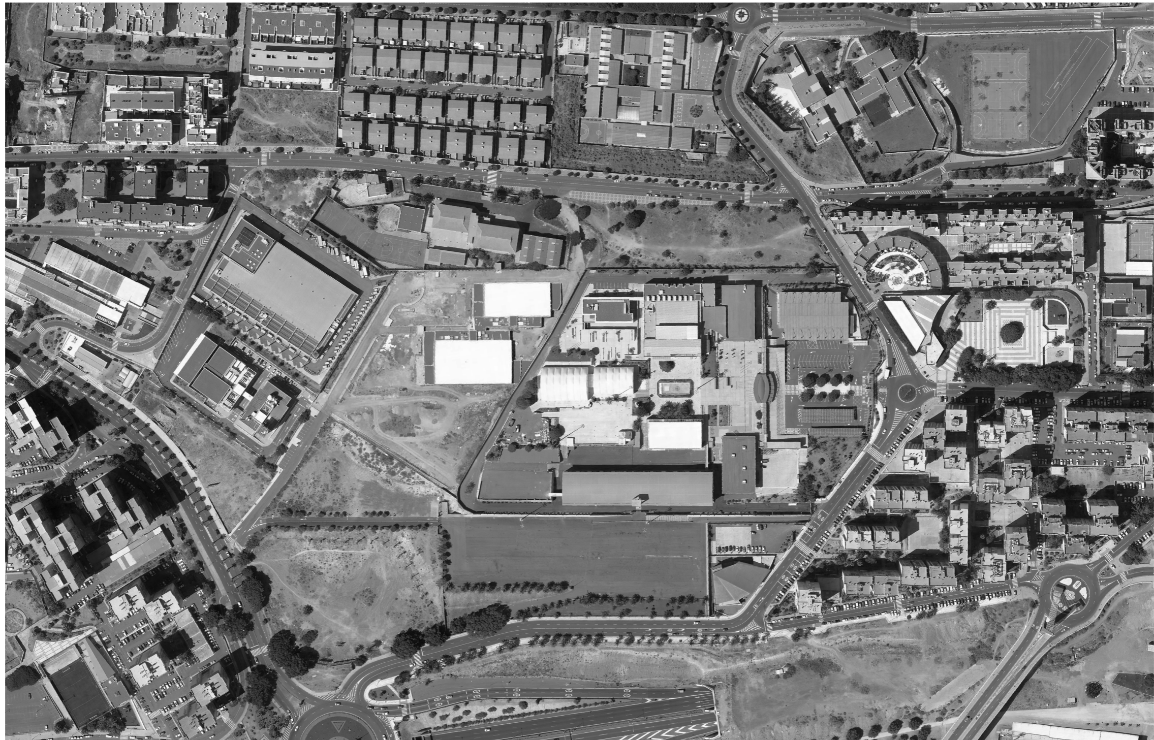
Estado actual del Recinto Ferial. Fuente: GRAFCAN.
