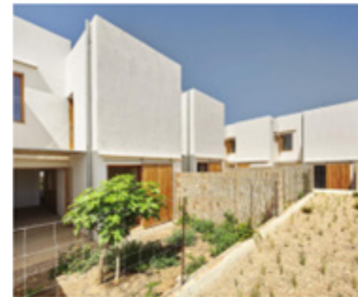
14 viviendas en Formentera. Fito - depuración
