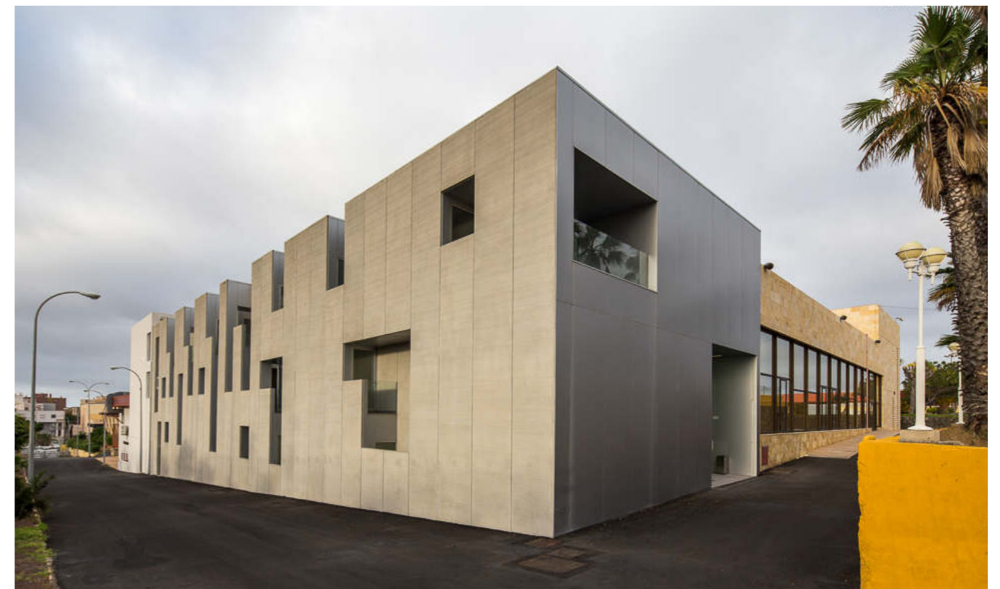
Alzado poniente del Edificio Incube. Fuente: LPA Studio.
