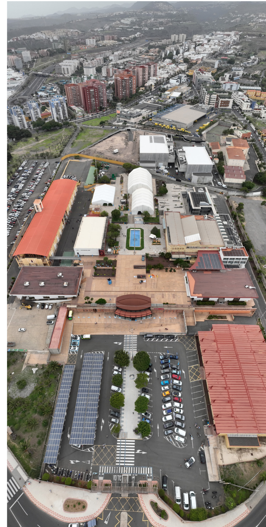
Vista aérea del Recinto Ferial de Canarias y sus preexistencias, cuya mayoría se integra en el modelo de ordenación. Fuente: INFECAR.
