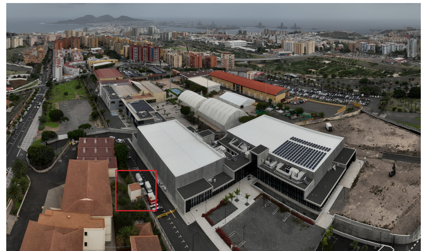
Vista aérea parcial en la que se aprecia el centro de transformación existente junto al vial de servicio poniente. Fuente: INFECAR.
