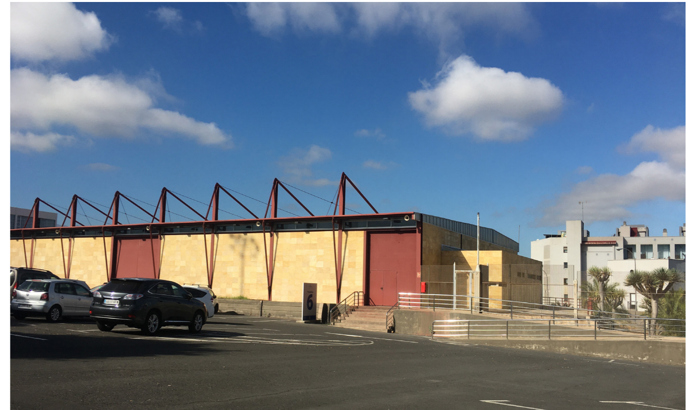
Fachada naciente del Pabellón 6, una de las preexistencias situadas en la zona norte del ámbito, junto a la entrada principal actual. Fuente: LPA Studio.
