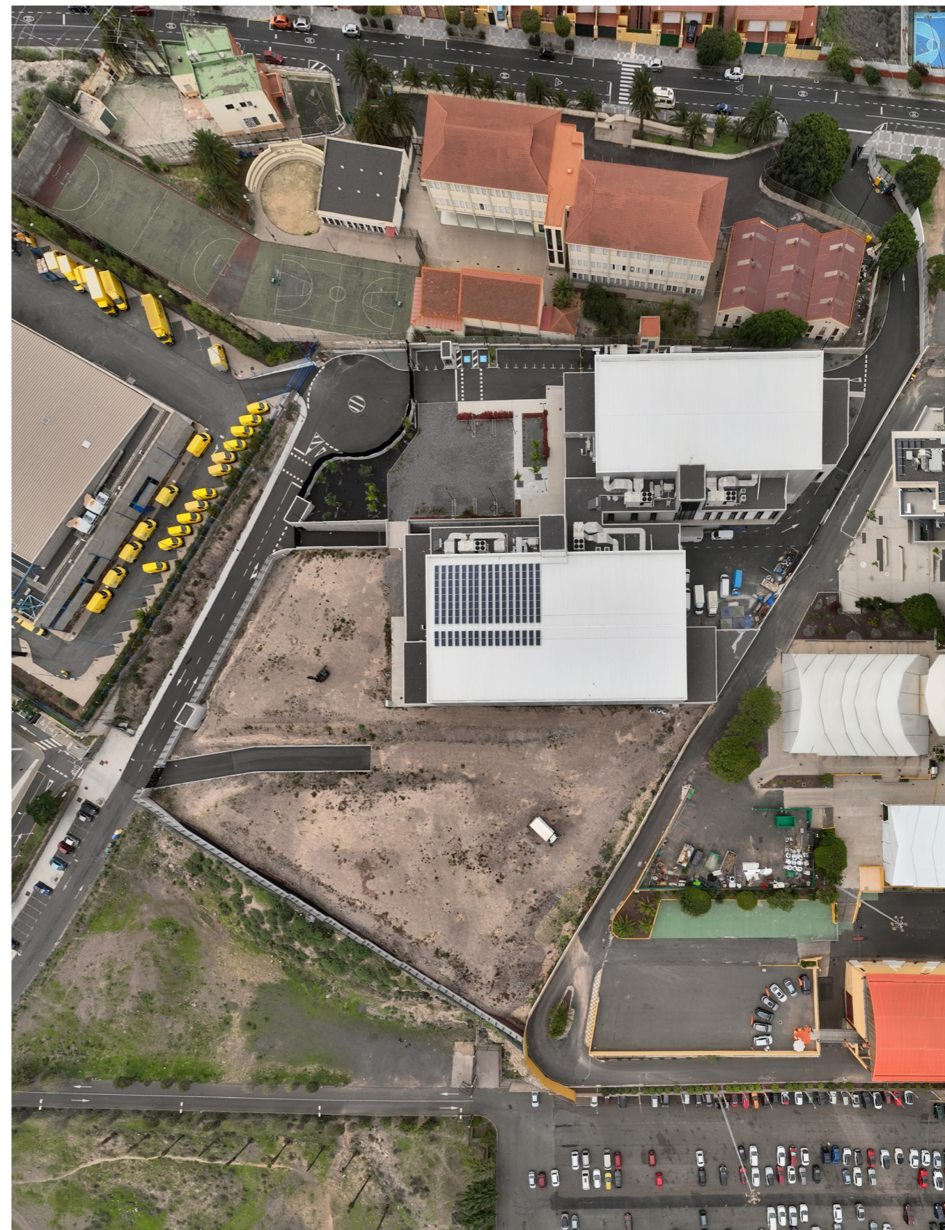
Vista aérea del CPA en su estado actual, que se incorpora al modelo de ordenación y se amplía. Fuente: INFECAR.
